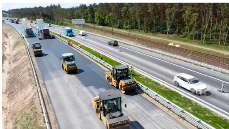
Fot. 4. Zagęszczanie warstwy ścieralnej na drodze S3, odc. Rzęśnia–Miękowo
