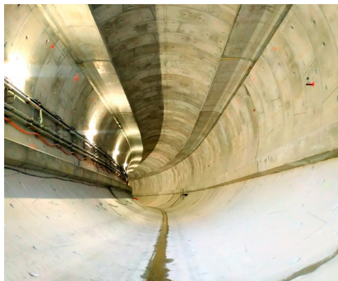
Budowa konstrukcji pod jezdnię i sufit w tunelu
