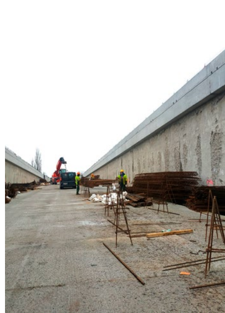
Budowa konstrukcji pod jezdnię i sufit w tunelu
