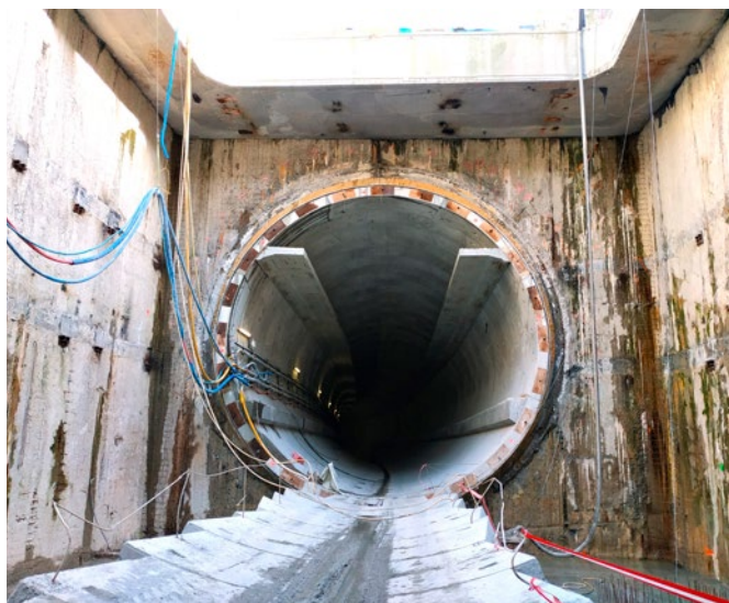
Komora startowa (budowa konstrukcji pod jezdnię i sufit w tunelu)
