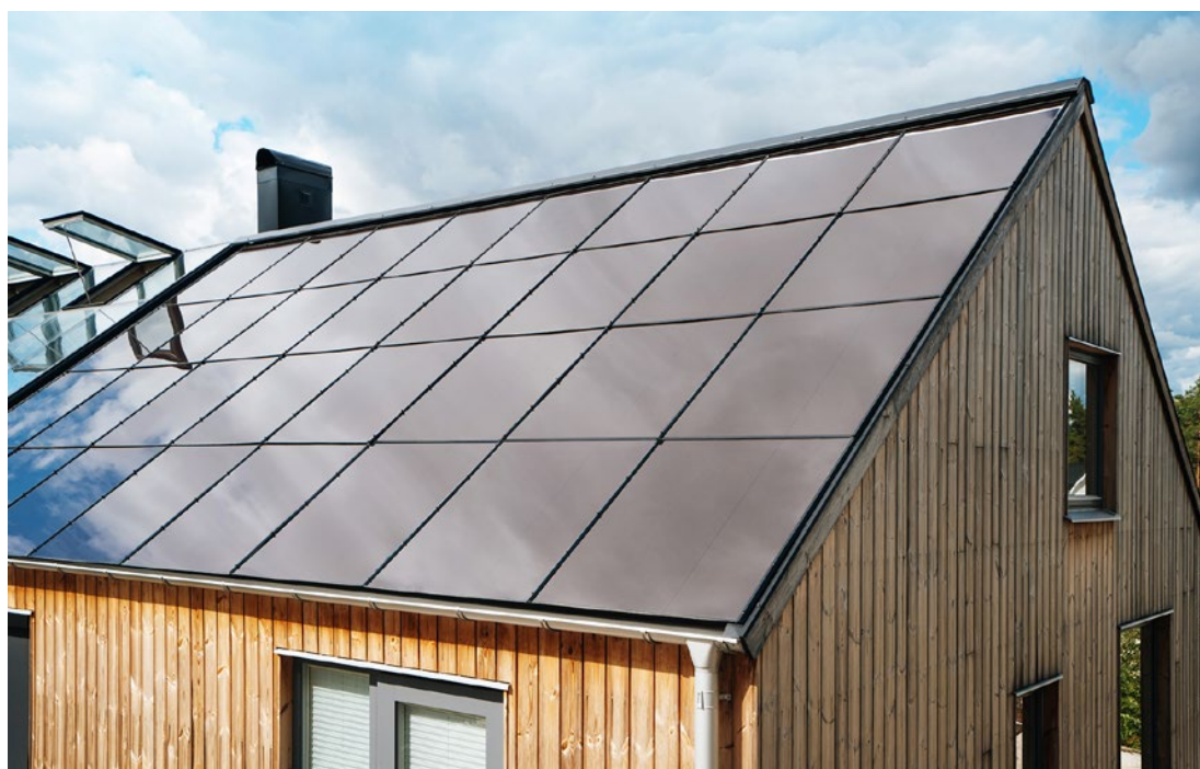
SunRoof – dach zintegrowany z ogniwami fotowoltaicznymi
