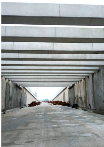
Budowa konstrukcji pod jezdnię i sufit w tunelu
