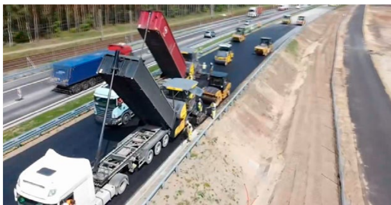
Fot. 3. Dowóz materiału do rozścielacza nawierzchni bitumicznej na drodze S3, odc. Rzęśnia–Miękowo
