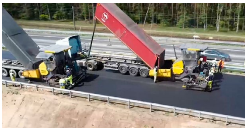
Fot. 2. Dowóz materiału do rozścielacza nawierzchni bitumicznej na drodze S3, odc. Rzęśnia–Miękowo
