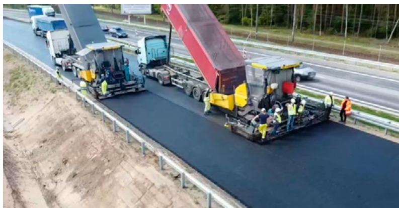
Fot. 1. Układanie nawierzchni warstwy ścieralnej na drodze S3, odc. Rzęśnia–Miękowo
